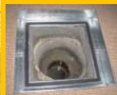
Смотровая шахта с насосом для откачивания воды:
