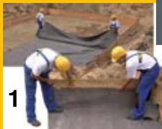
Заделка герметизирующего полотна (деталь)
